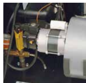
En-faset motor koblet til vifte og dieselpumpe.
